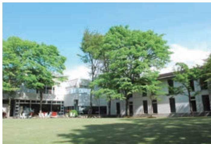
中庭から望む 本館 ターミナル棟
